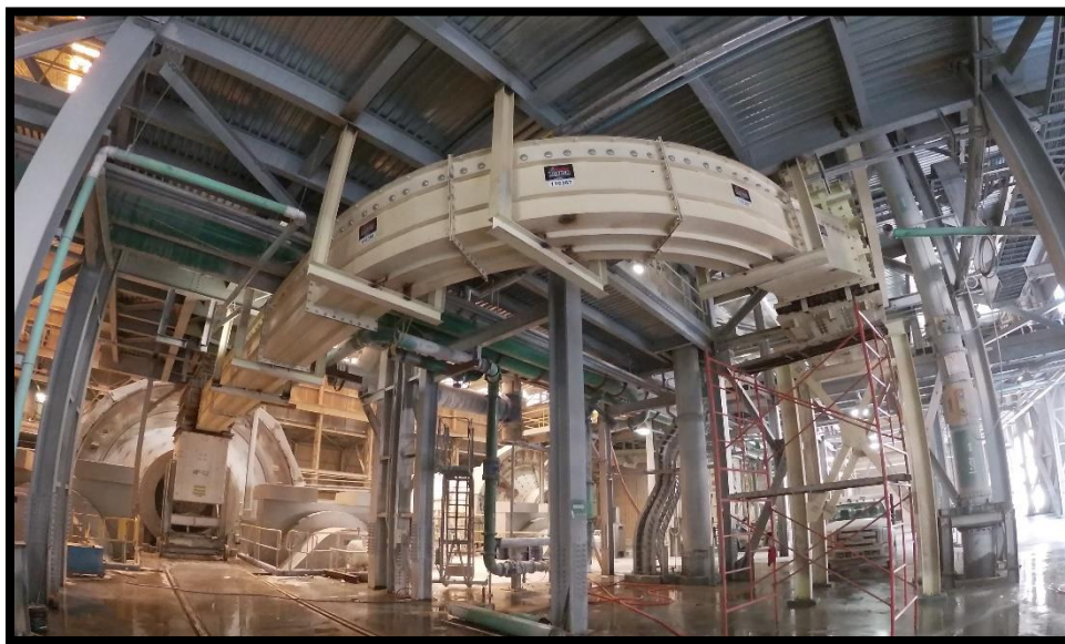
Después: Nuevo Sistema instalado por Valley Rubber.
