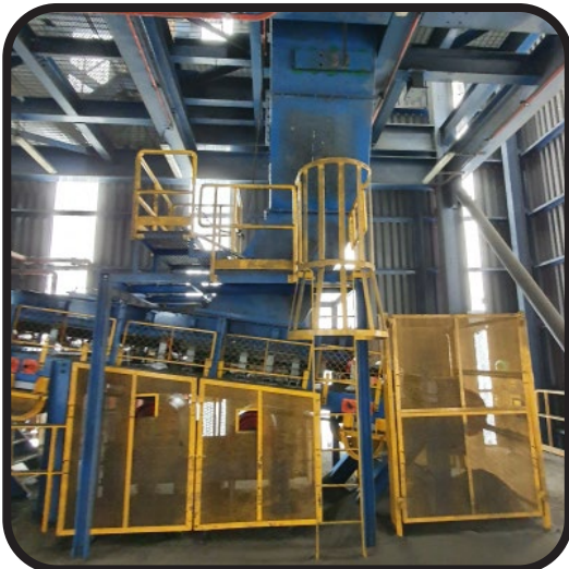
Antes de se instalara el Sistema de Valley Rubber
