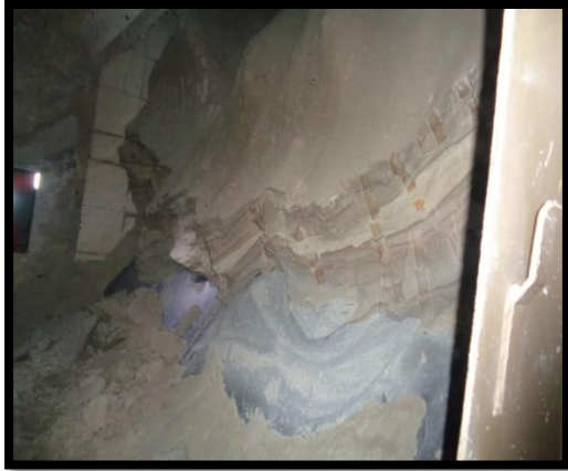
Foto de arriba: Taponamiento extremo debido a la falla del sistema de la competencia.
