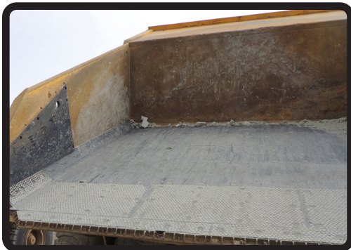
Revestimiento de Tolvas de Camiones – Revestimientos de Descarga
