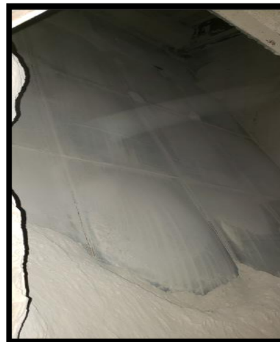
Foto de arriba: Revestimiento Inflable de Valley Rubber después de 1 año de funcionamiento sin fallas.
